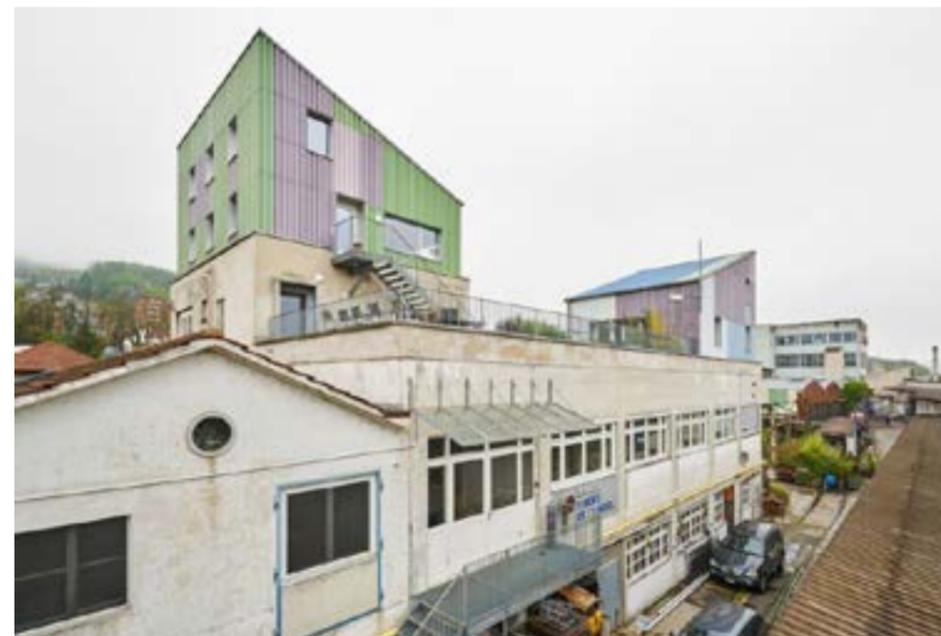
Vorgemacht, wie es gehen könnte: Im Walzwerk in Münchenstein bei Basel wurden die aufgestockten Kuben in vorgefertigter Holzbauweise errichtet und heben sich klar als Aufbauten von den Betongebäuden ab.
