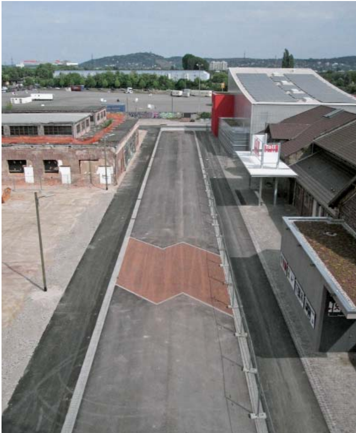
ALT UND NEU AUF DEM VIEHHOF Links die Schweinemarkthalle vor dem Umbau, rechts das Tollhaus mit neuem Anbau. Dazwischen sind bereits die neuen Straßen- und Parkierungsflächen hergestellt.
