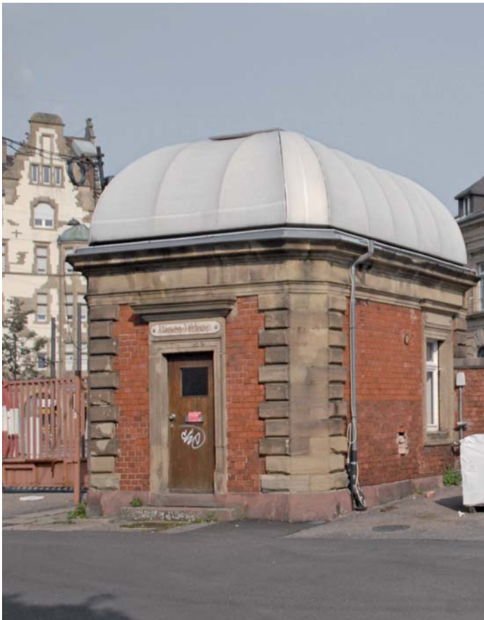
AS 09 PFÖRTNERHAUS SCHLACHTHOF Die Lichtkuppel ist den ursprünglichen Dachaufsätzen nachempfunden.
